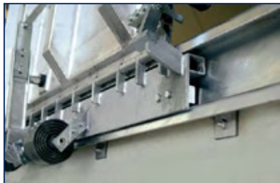
Placas de acero de 80 x 80 x 10 mm fijadas con anclas de pared contra la obra por debajo del raíl-guía ó por debajo de la placabase si la pasarela es estacionaria. Soldadura inferior!
