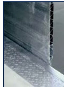
Soldadura de unión entre raíl-guía y chapa superior. Soldadura superior!
