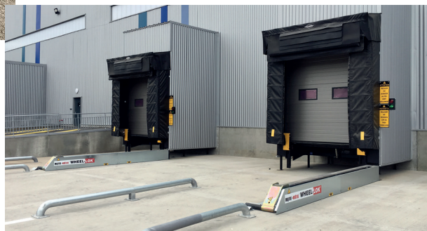
Les dispositifs de guidage des roues permettent de positionner la remorque de manière centrée à chaque fois.
