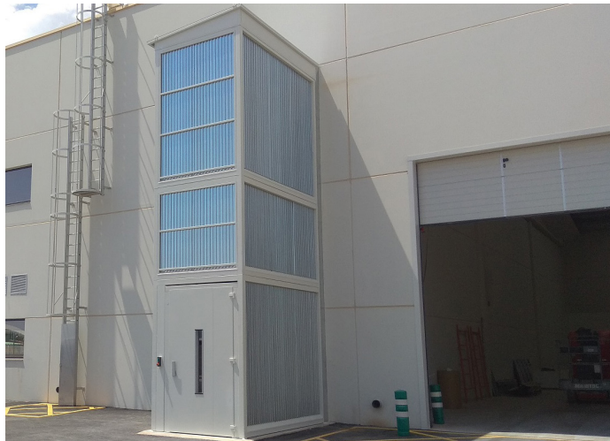
PLT con cerramiento en chapa Pegaso.
