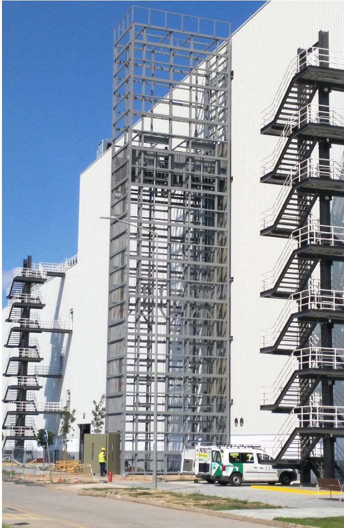
PLT con cerramiento en chapa deploye
