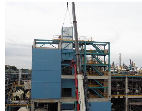
MONTAJE CON ACCESO FRONTAL CON GRÚA Y POLEA:
