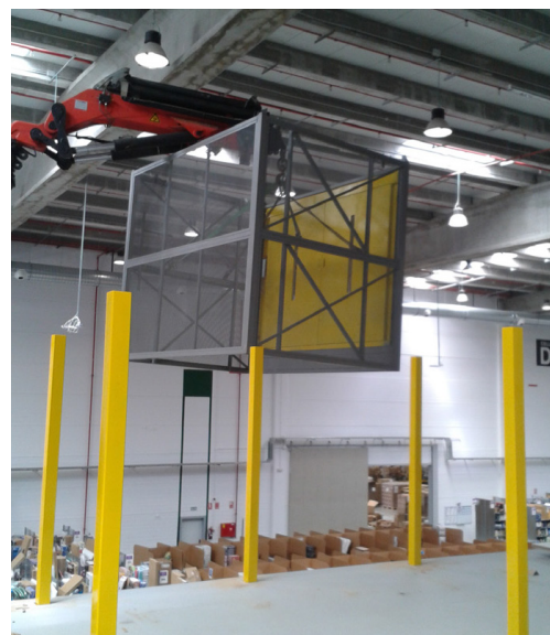
MONTAJE CON PÓRTICO LIGERO:
